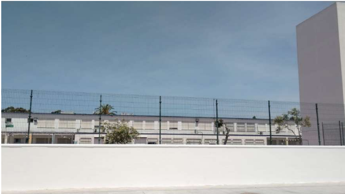
El nuevo muro del colegio, que se ha reparado recientemente.
