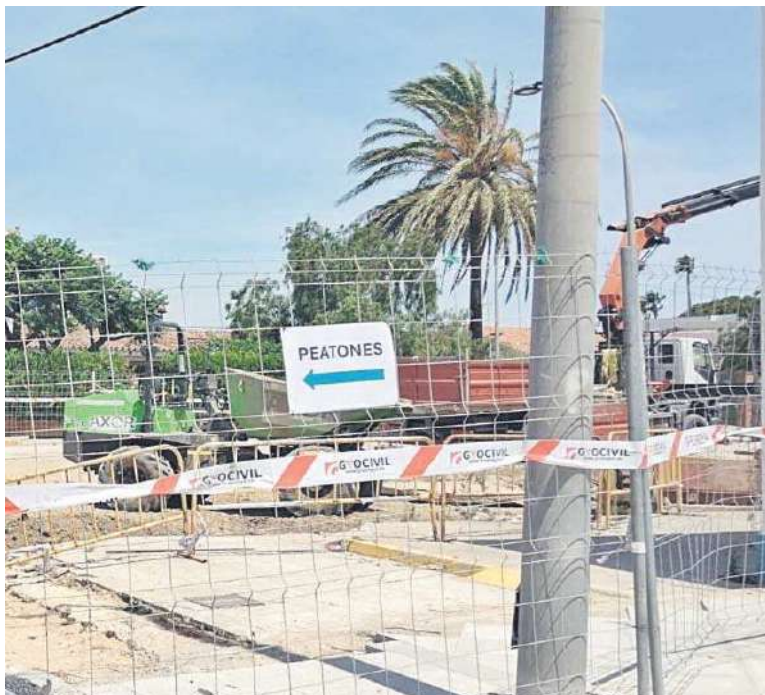
Parte de la rotonda de La Puntilla aún está levantada por las obras.
