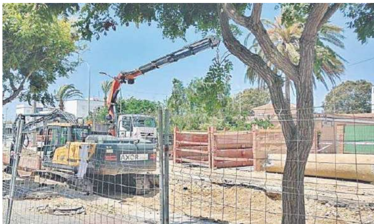
Otra imagen de los trabajos que se están ejecutando estos días.
