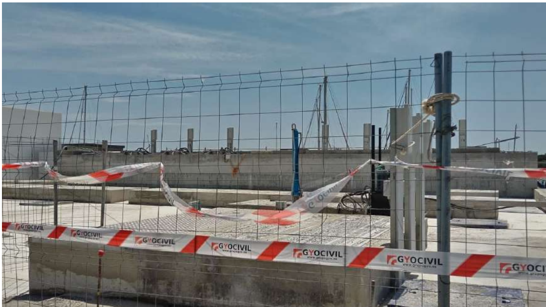
El tanque anticontaminación ya está terminado, a falta de algunos flecos.
