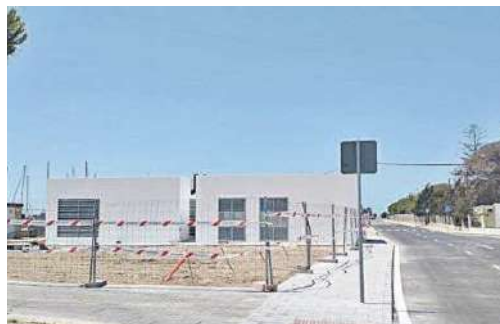
Los módulos que sustituyen a la antigua estación de bombeo.
