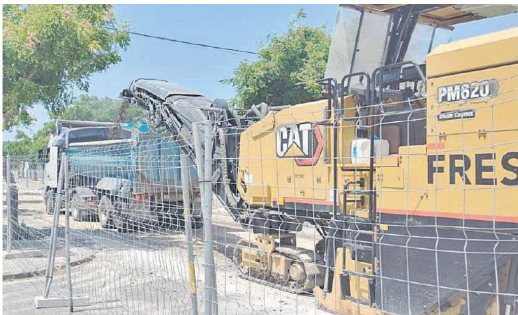
La maquinaria pesada trabaja ahora en la calle Aurora para soterrar las tuberías que llegan hasta el tanque.
